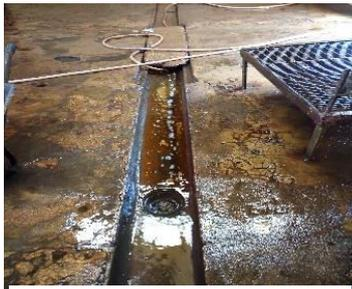
**Photo 5 :** Rigoles à ciel ouvert conduisant les eaux usées vers la fosse de décantation
