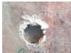
Figure 10. Actual Drilled hole
