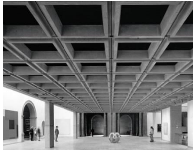
Fig. 2 Waffle Slab
