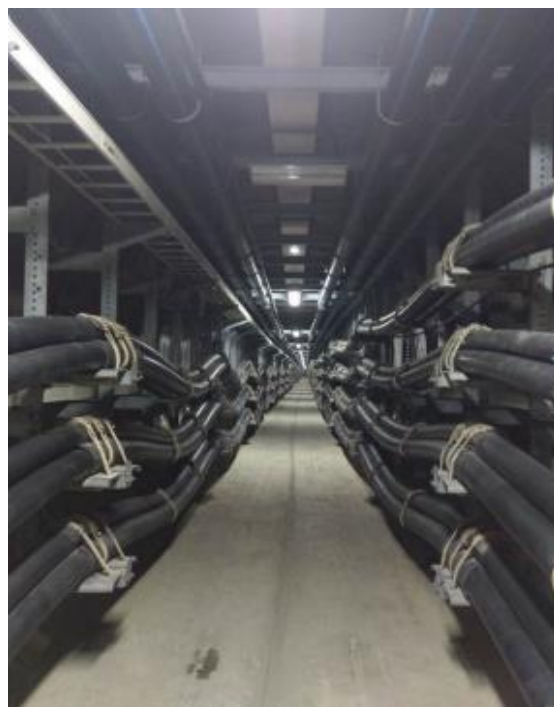
Fig. 2. Actual underground cable tunnel 2.
