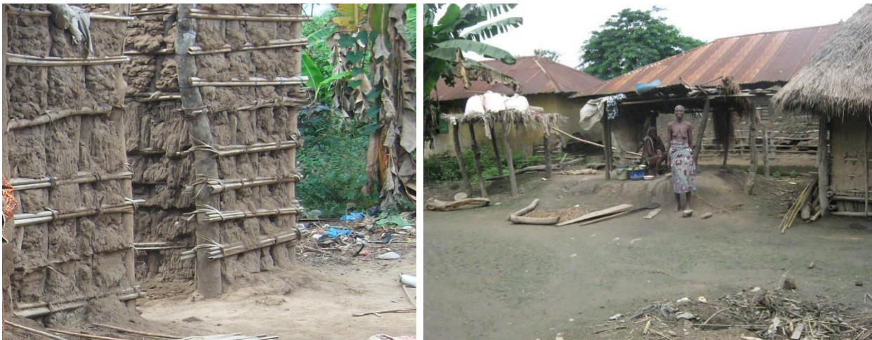
Photo 2 : Stratégie de construction de cases en banco à Ouinhi
